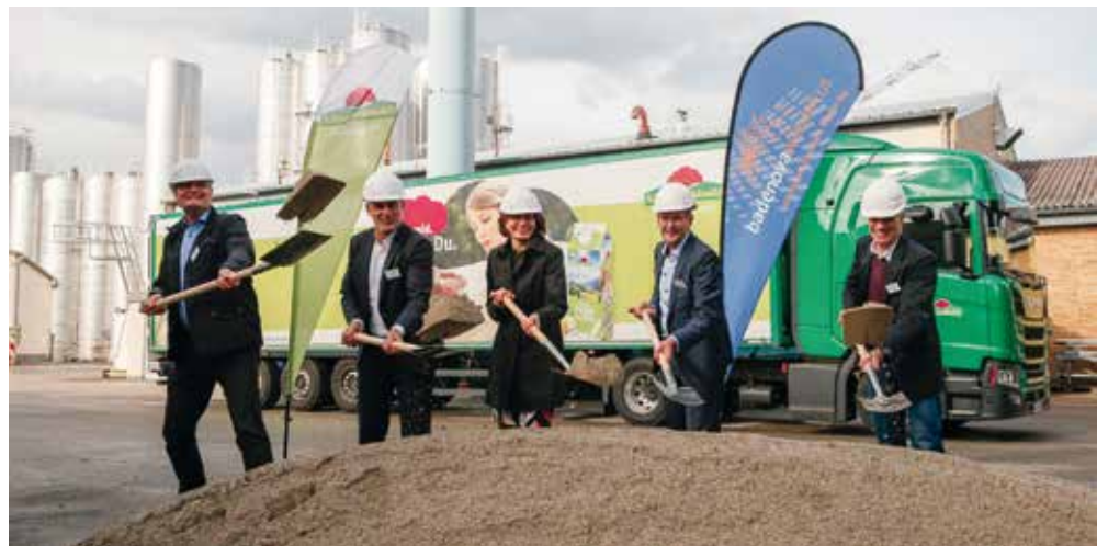
Spatenstich und Startschuss für Freiburgs Wärmeversorgung der Zukunft mit Klaus Preiser (Geschäftsführer badenovaWÄRMEPLUS), Andreas Schneider (Geschäftsführer Schwarzwaldmilch), Umweltbürgermeisterin Christine Buchheit , Heinz-Werner Hölscher (badenova Vorstand) und Michael Klein (Geschäftsführer badenovaWÄRMEPLUS).
