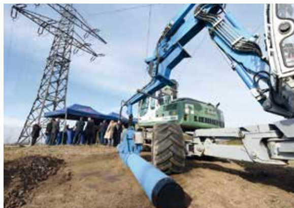
Vernetzte Trinkwasser-Infrastruktur: Von ihrem Wasserwerk in Hausen a. d. Möhlin versorgt badenova nicht nur ganz Freiburg mit hochwertigem Trinkwasser, sondern seit 2020 auch Breisach und einige Nachbarorte. Hier ein Bild vom offiziellen Baubeginn der Leitungsverlegung.
